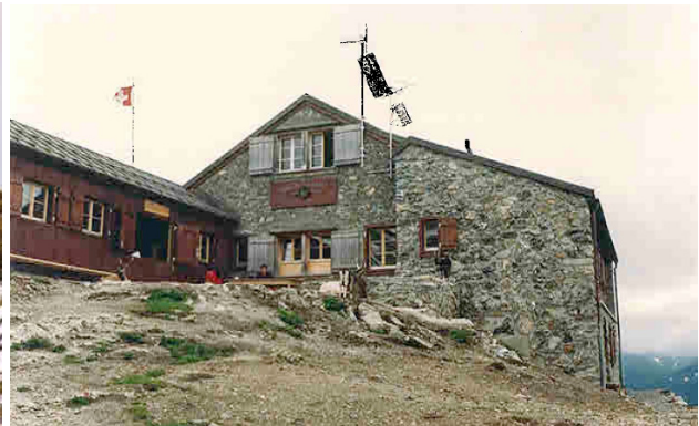
Windgällenhütte mit 1. Anbau von Südwesten
