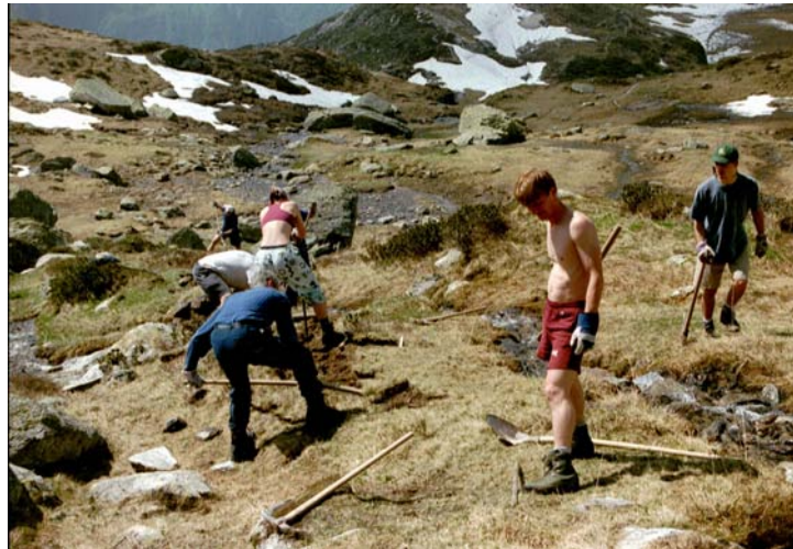
Aktive beim Bau für die neue Wasserleitung
