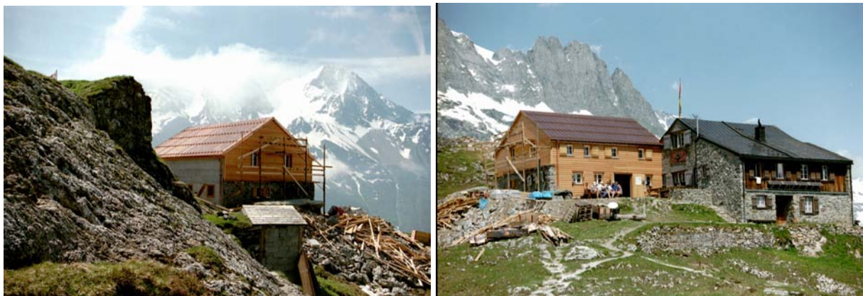
Der neue Anbau kurz vor der Fertigstellung im Juli 2001 Anbau zusammen mit dem Altbau
