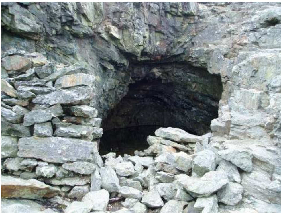
Bild 8. Bergvägg med gruvgång och spår av minst två olika brytningsmetoder. Den inre delen av gruvgången är klassiskt tillmakad med rundad, tämligen slät yta. I och utanför öppningen har berget borrhål och är mer söndertrasat av krutsprängning. Därutöver finns även spår efter bearbetning för hand. Framför ingångsöppningen är ett delvis raserat bolvärke av kallmurade stenar. Från Gammelgruvan, nr 5e enligt fig. 2. Foto: L. Klang.
