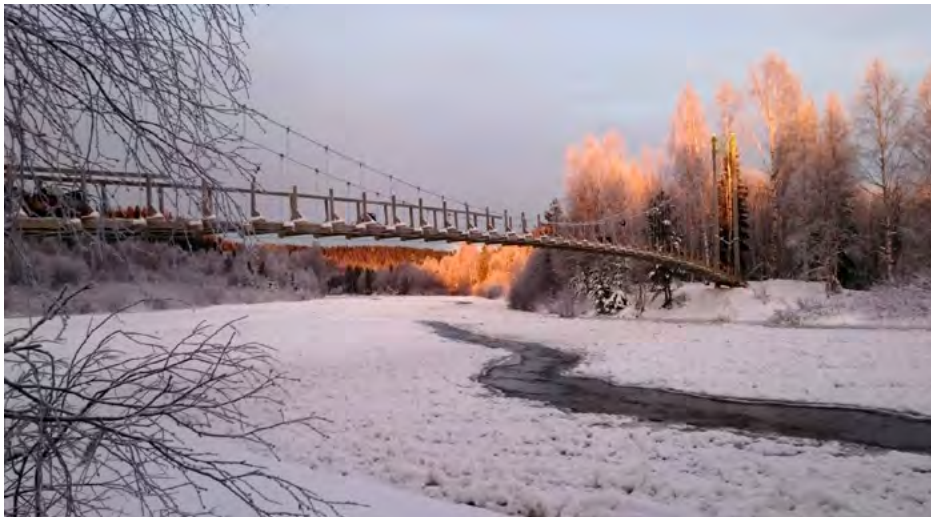
Den nya gångbron över Öreälven i Lagnäsets naturreservat blev klar i december 2017. Foto: Kurt Åkesson
